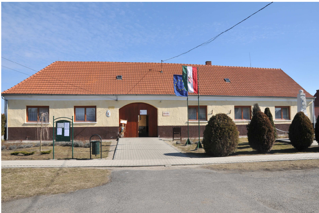
Az általános iskola főbejárata
